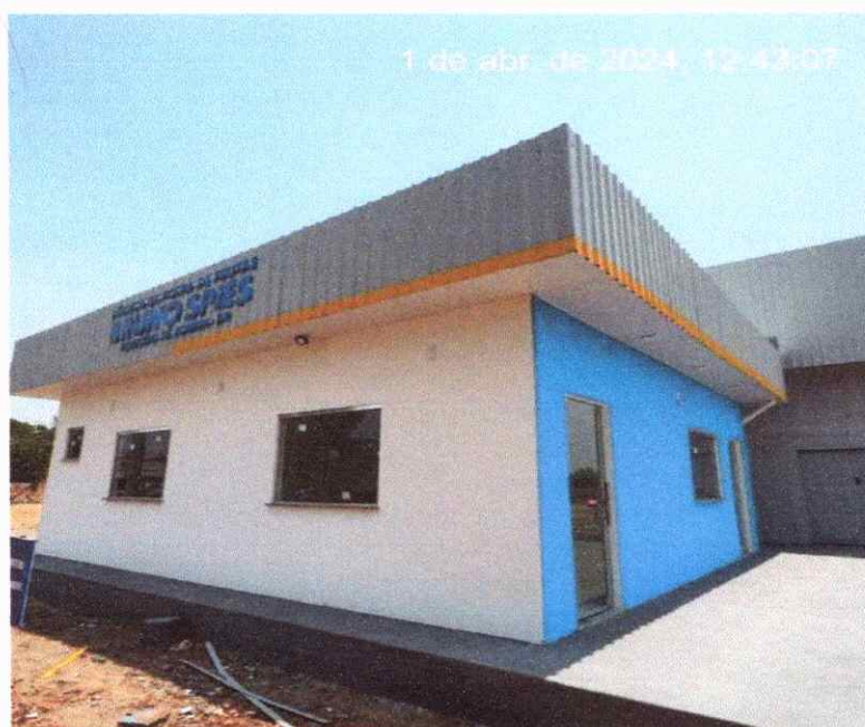
Figura 12: PINTURA EXTERNA DA ALVENARIA E DO FECHAMENTO LATERAL
