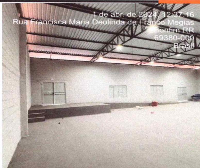
Figura 7: PINTURA INTERNA DA ALVENARIA E INSTALAÇÕES DE REFLETORES
