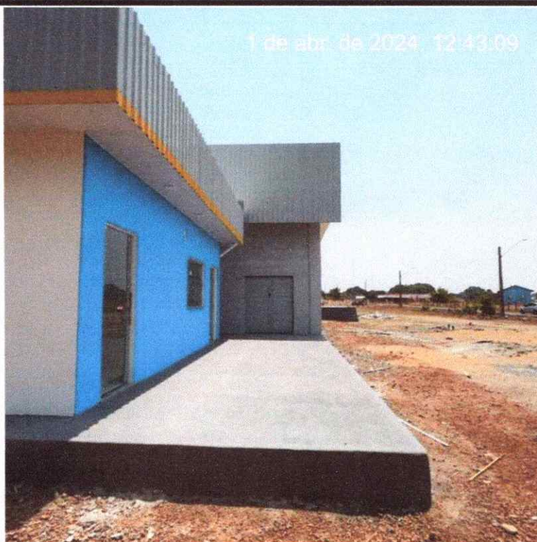
Figura 11: PINTURA EXTERNA DA ALVENARIA E DO FECHAMENTO LATERAL
