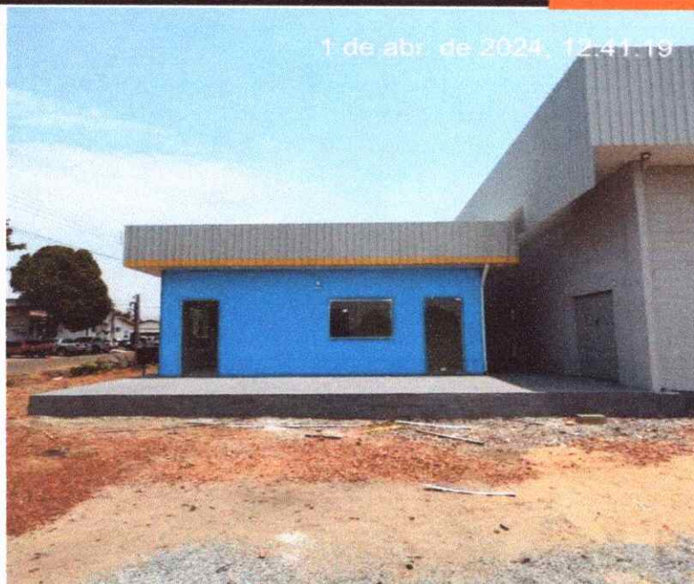
Figura 13: PINTURA EXTERNA DA ALVENARIA E DO FECHAMENTO LATERAL
