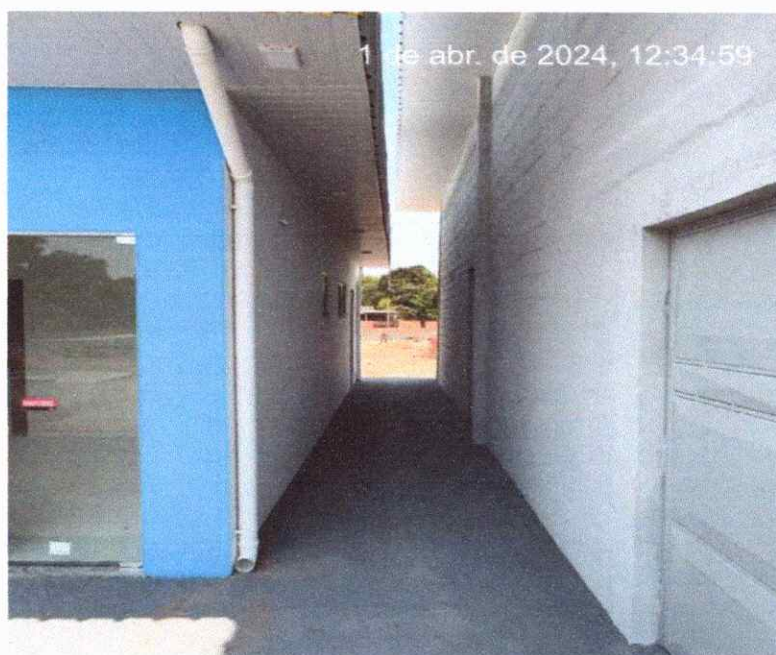
Figura 20: PINTURA EXTERNA DA ALVENARIA E DO FECHAMENTO LATERAL
