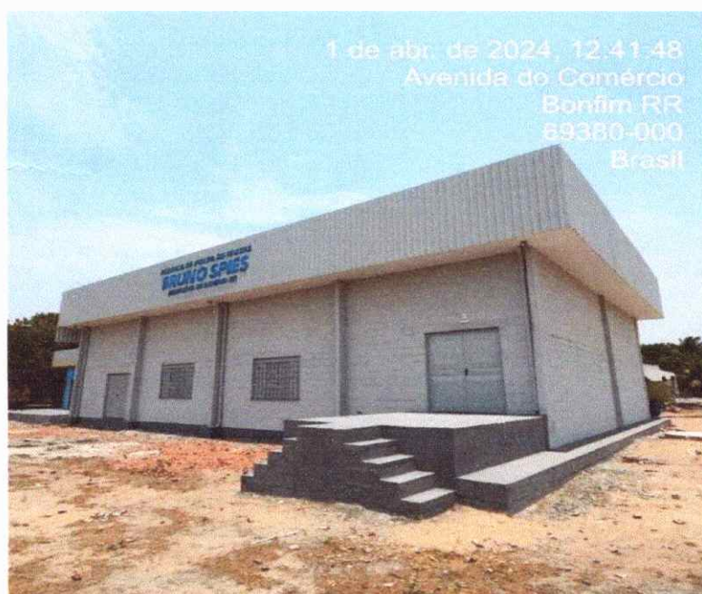
Figura 2: PINTURA EXTERNA DA ALVENARIA E DO FECHAMENTO LATERAL
