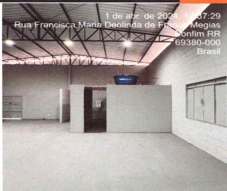
Figura 3: PINTURA INTERNA DA ALVENARIA E INSTALAÇÕES DE REFLETORES
