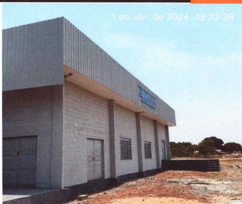
Figura 27: PINTURA EXTERNA E DO FECHAMENTO LATERAL EM TINTA ESMALTE SINTÉTICO
