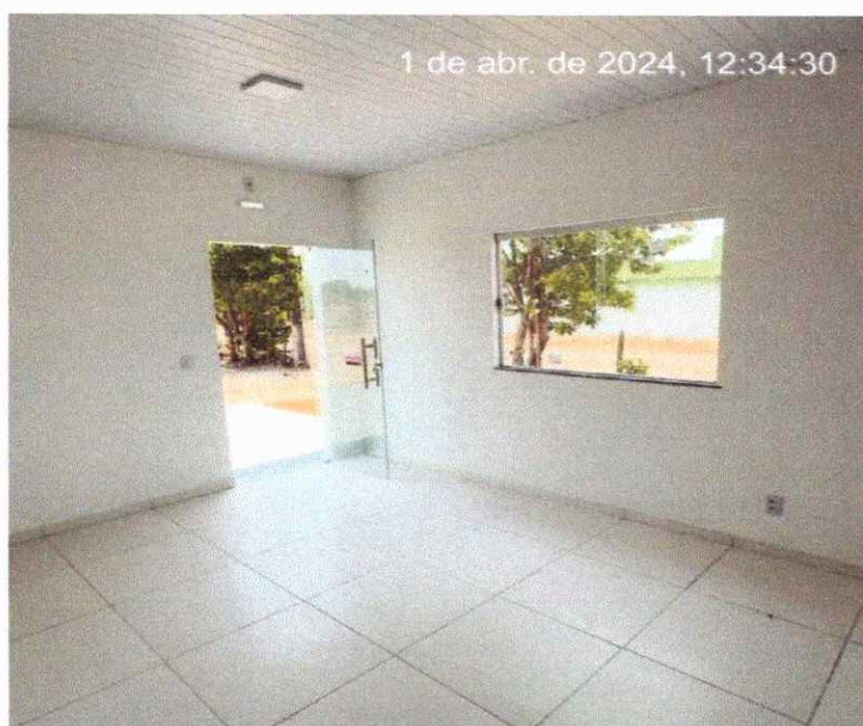
Figura 22: REVESTIMENTO INTERNO E INSTALAÇÃO DE PORTAS E JANELAS EM VIDRO TEMPERADO
