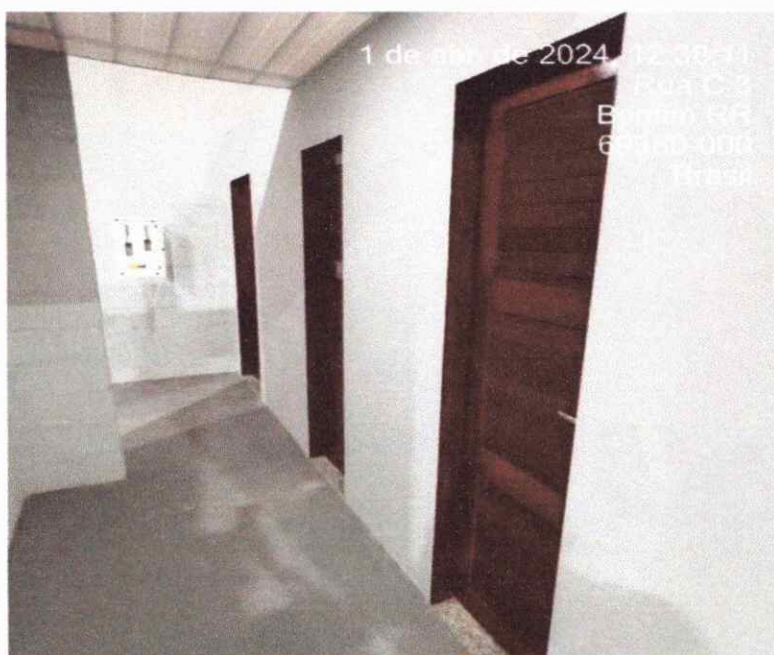
Figura 6: PINTURAS DE PORTAS E ALVENARIAS
