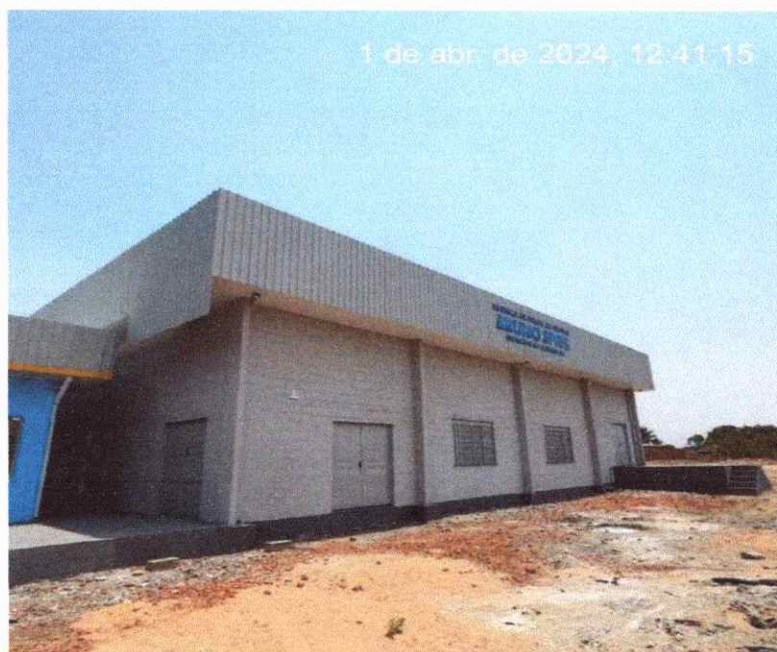
Figura 14: PINTURA EXTERNA DA ALVENARIA E DO FECHAMENTO LATERAL
