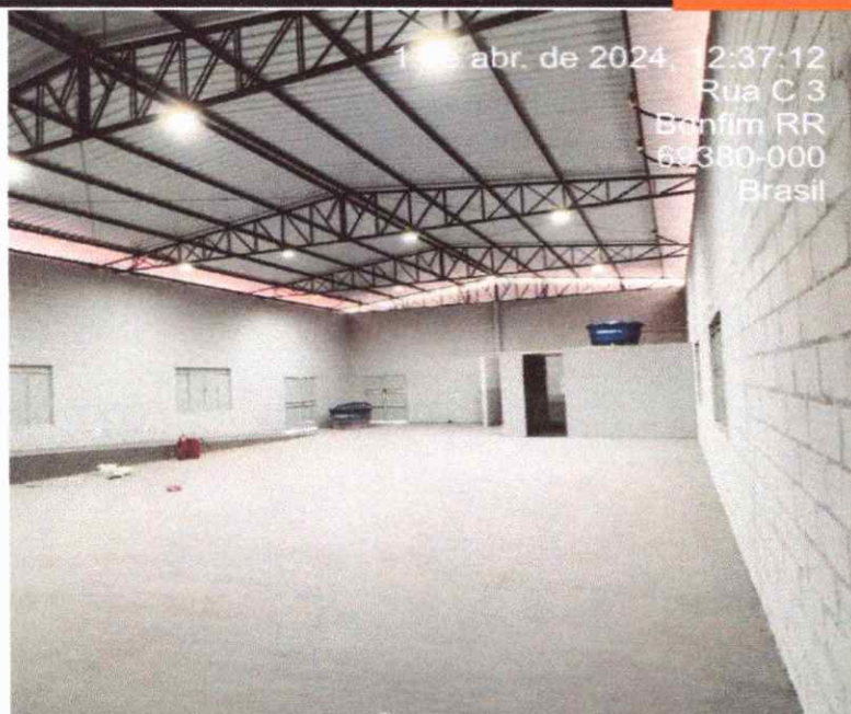
Figura 5: PINTURA INTERNA DA ALVENARIA E INSTALAÇÕES DE REFLETORES
