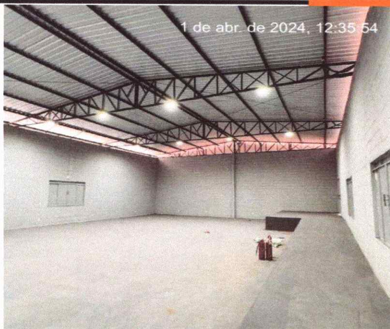
Figura 19: PINTURA DO PISO E INSTALAÇÃO DE REFLETORES
