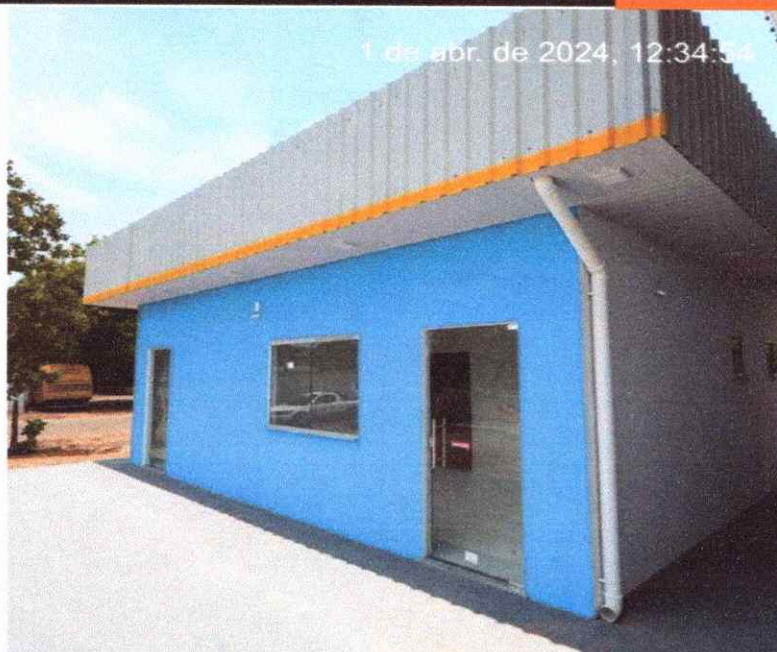
Figura 21: INSTALAÇÃO DE PORTAS EM VIDRO TEMPERADO E PINTURA EXTERNA
