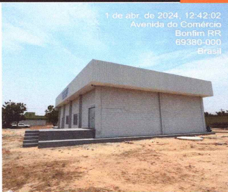
Figura 1: PINTURA EXTERNA DA ALVENARIA E DO FECHAMENTO LATERAL
