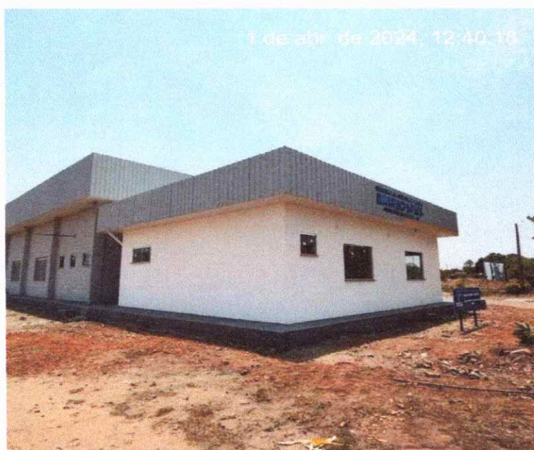
Figura 16: PINTURA EXTERNA DA ALVENARIA E DO FECHAMENTO LATERAL
