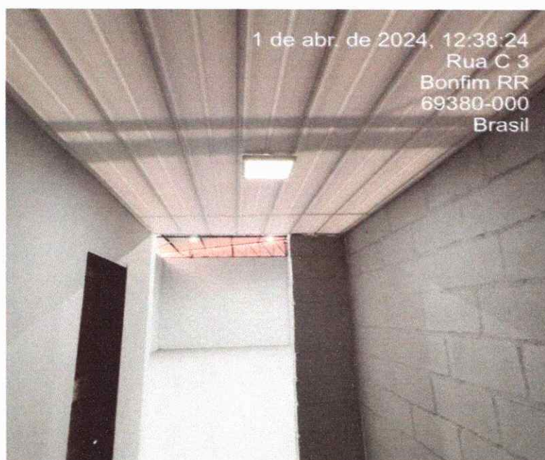
Figura 8: INSTALAÇÃO DE FORRO E LUMINÁRIA
