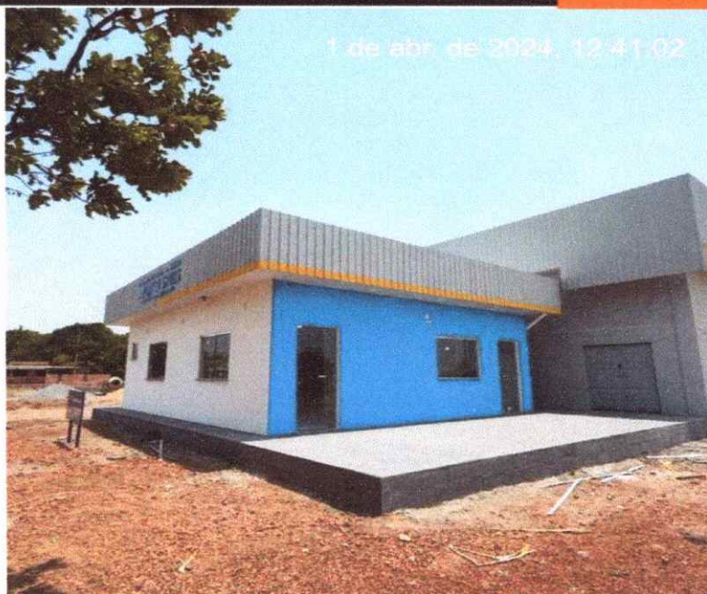
Figura 15: PINTURA EXTERNA DA ALVENARIA E DO FECHAMENTO LATERAL
