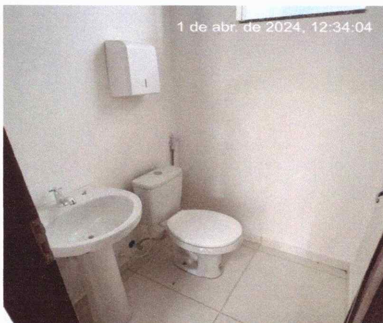
Figura 24: INSTALAÇÃO DE LOUÇAS DO BANHEIRO DA PARTE ADMINISTRATIVA
