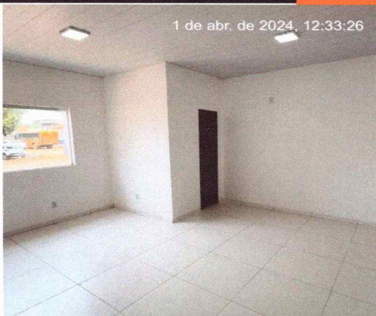
Figura 25: REVESTIMENTO INTERNO E INSTALAÇÃO DE PORTAS E JANELAS EM VIDRO TEMPERADO
