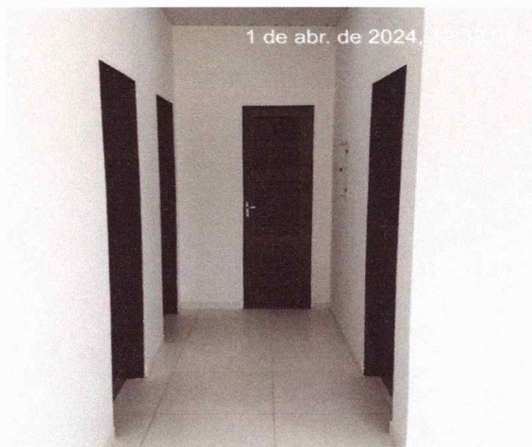
Figura 26: INSTALAÇÃO E PINTURA DE PORTAS DE MADEIRA
