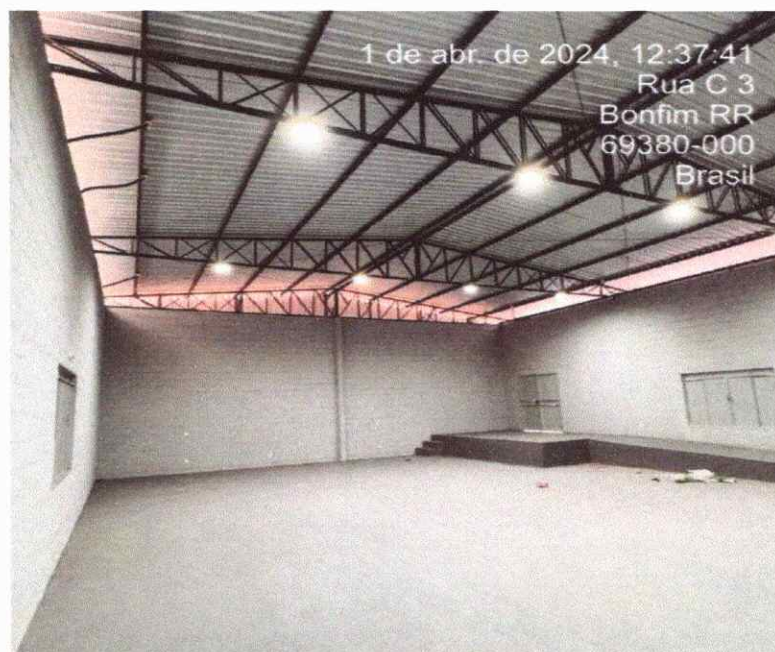
Figura 4: PINTURA INTERNA DA ALVENARIA E INSTALAÇÕES DE REFLETORES
