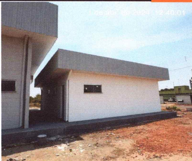
Figura 17: PINTURA EXTERNA DA ALVENARIA E DO FECHAMENTO LATERAL
