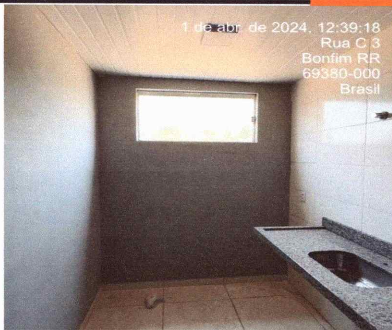
Figura 9: REVESTIMENTO DO BANHEIRO
