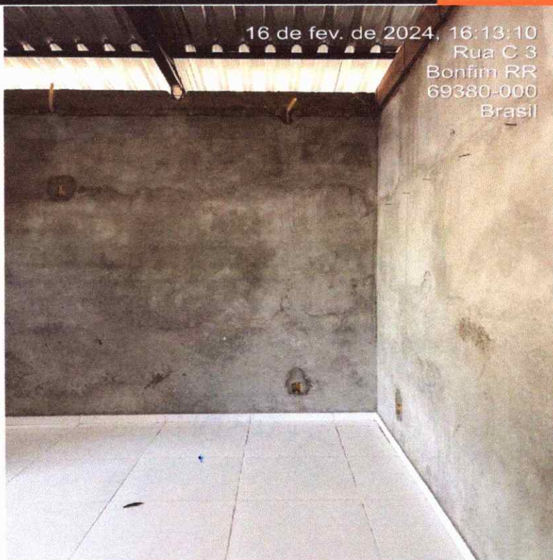
Figura 27: revestimento cerâmico do piso
