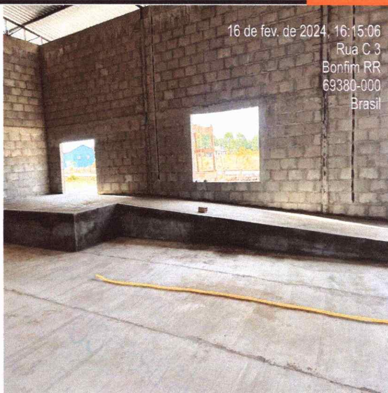
Figura 31: piso em concreto armado do galpão
