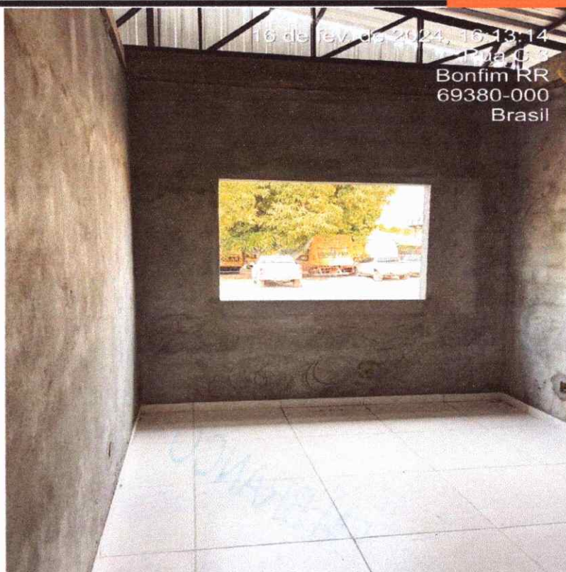
Figura 29: revestimento cerâmico do piso
