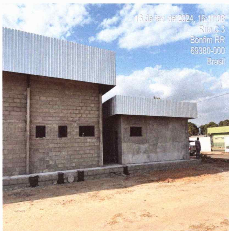
Figura 12: alvenaria de vedação em bloco de concreto
