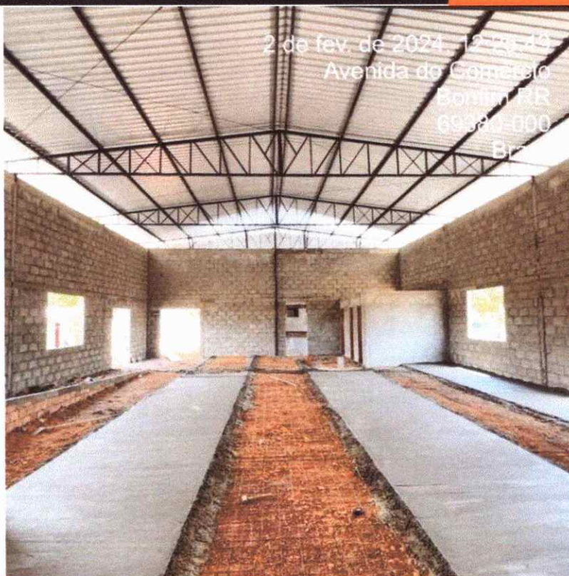
Figura 9: piso em concreto armado do galpão
