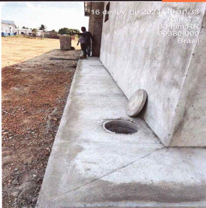
Figura 21: calçada lateral com caixa de passagem
