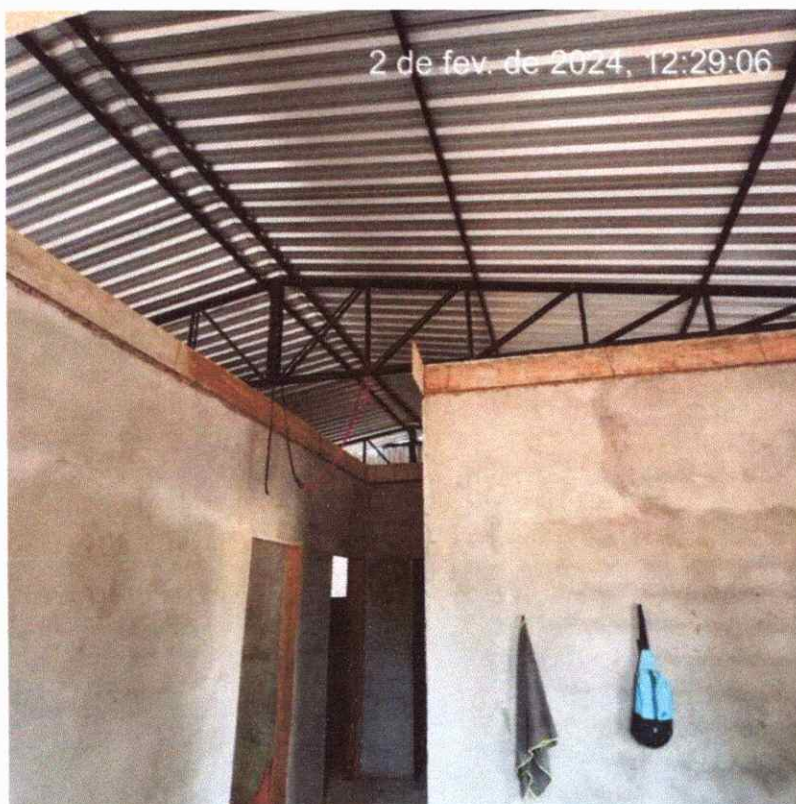
Figura 6: estrutura metálica da parte administrativa
