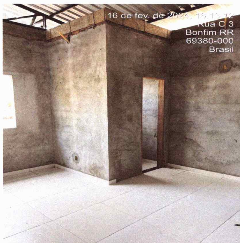
Figura 30: revestimento cerâmico do piso
