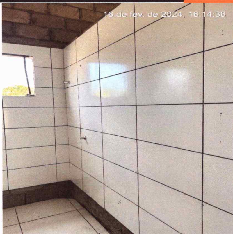
Figura 33: revestimento cerâmico parede e piso dos banheiros do galpão
