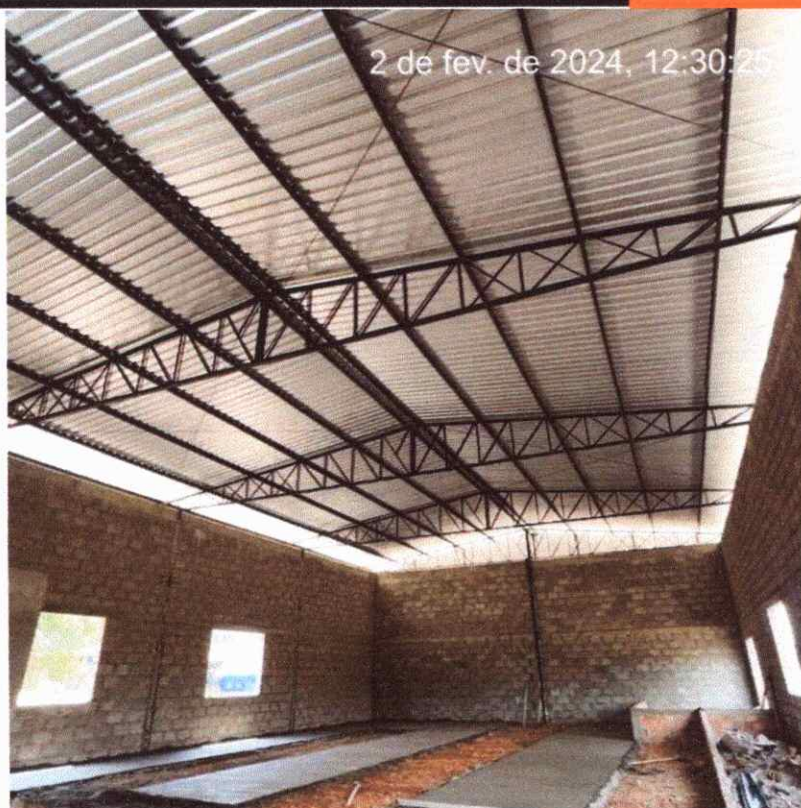
Figura 5: tesouras metálicas do galpão
