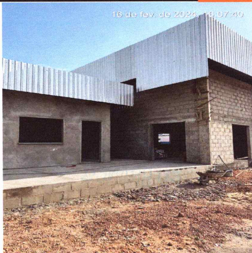
Figura 17: estrutura metálica do galpão e da parte administrativa
