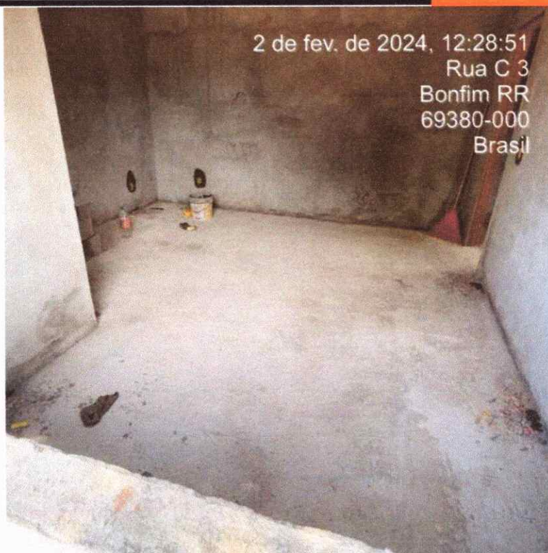
Figura 7: contrapiso da parte administrativa
