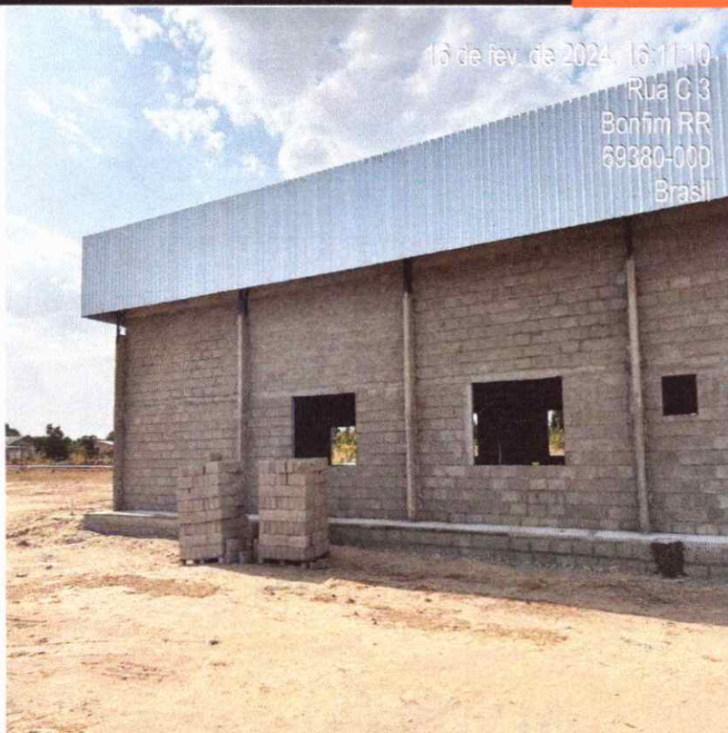
Figura 13: alvenaria de vedação em bloco de concreto
