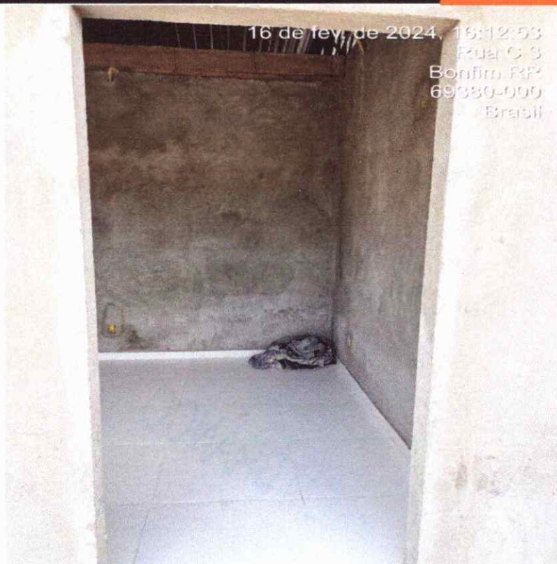
Figura 25: revestimento cerâmico do piso
