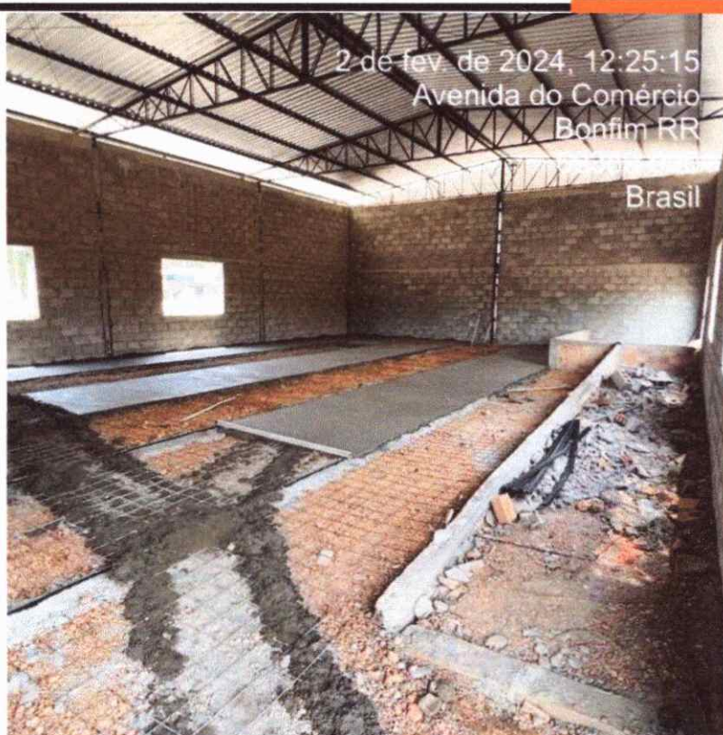
Figura 11: piso em concreto armado do galpão
