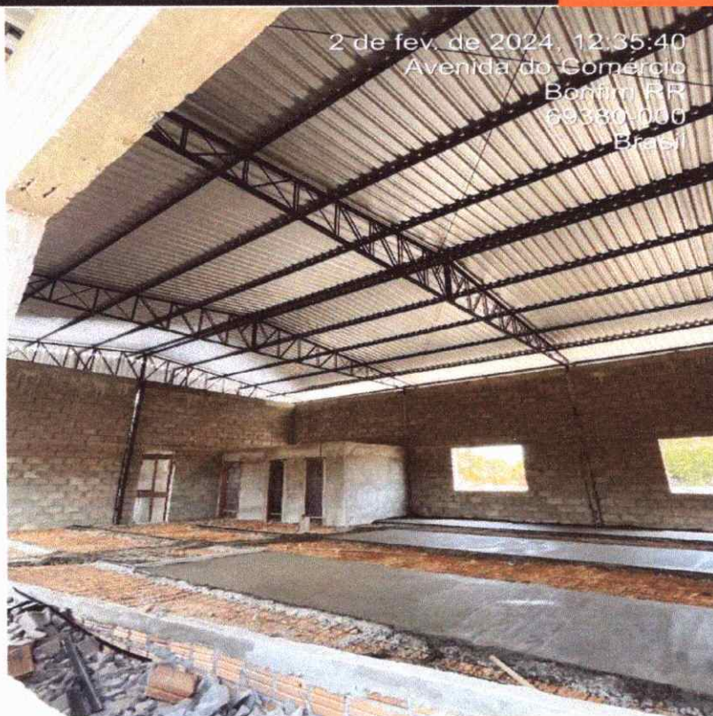
Figura 3: estrutura metálica do galpão
