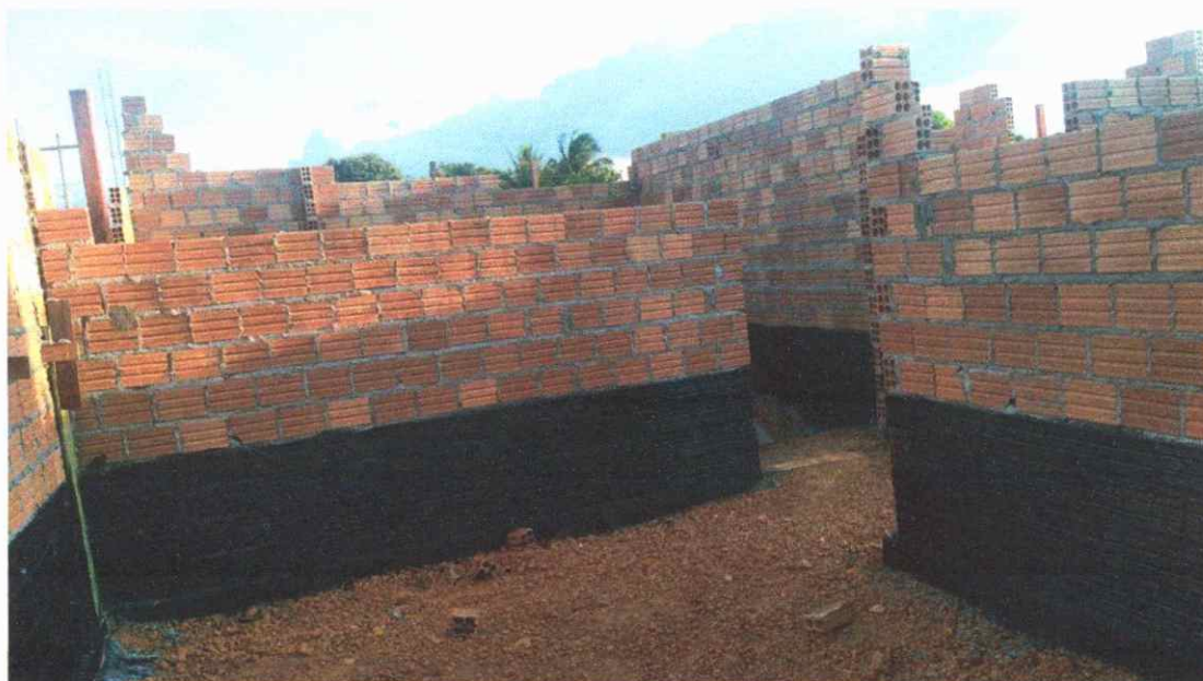
Figura 18: alvenaria de vedação impermeabilizada
