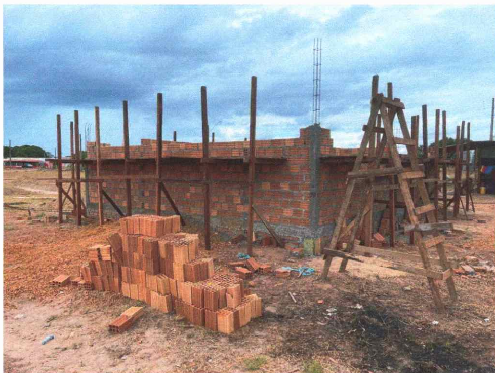
Figura 8: alvenaria de vedação - parte administrativa
