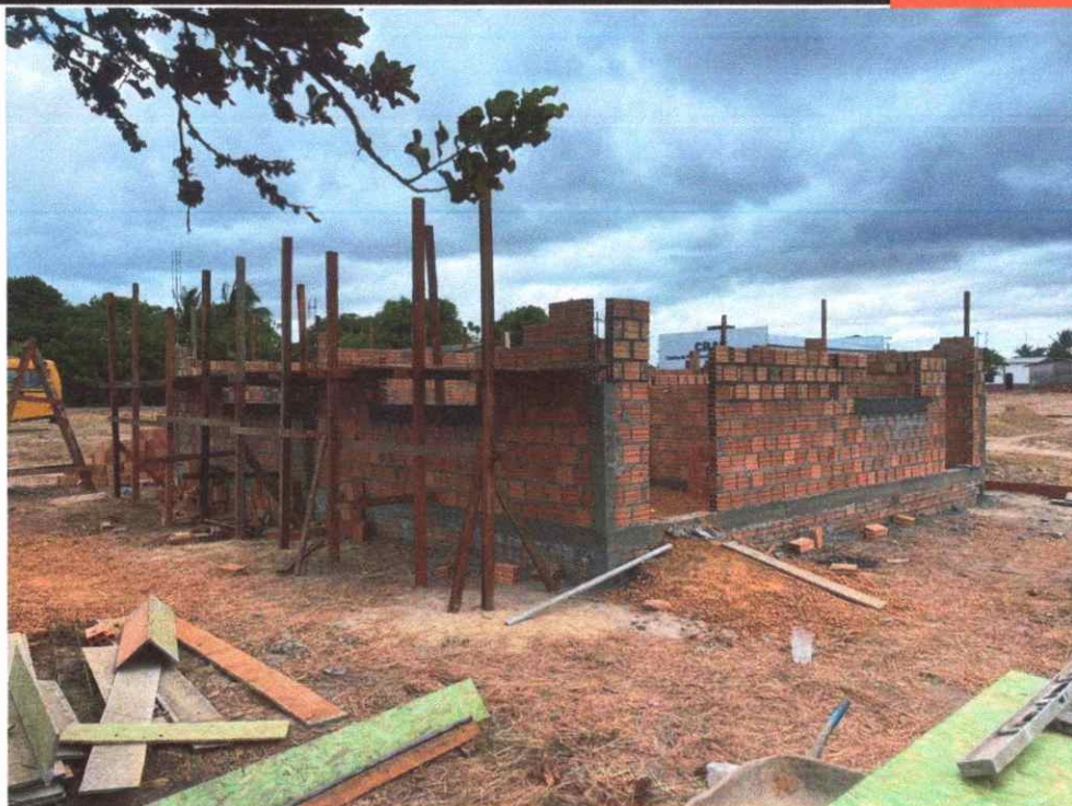
Figura 9: alvenaria de vedação - parte administrativa
