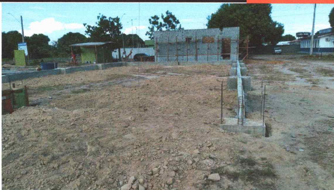
Figura 27: viga baldrame concretada - parte GALPÃO
