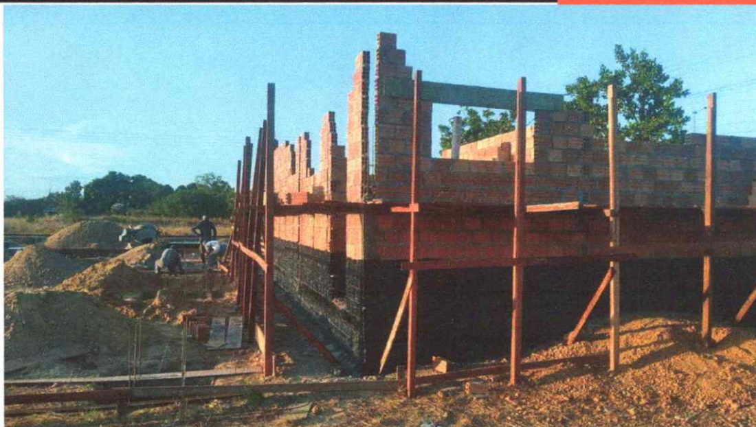
Figura 17: alvenaria de vedação impermeabilizada
