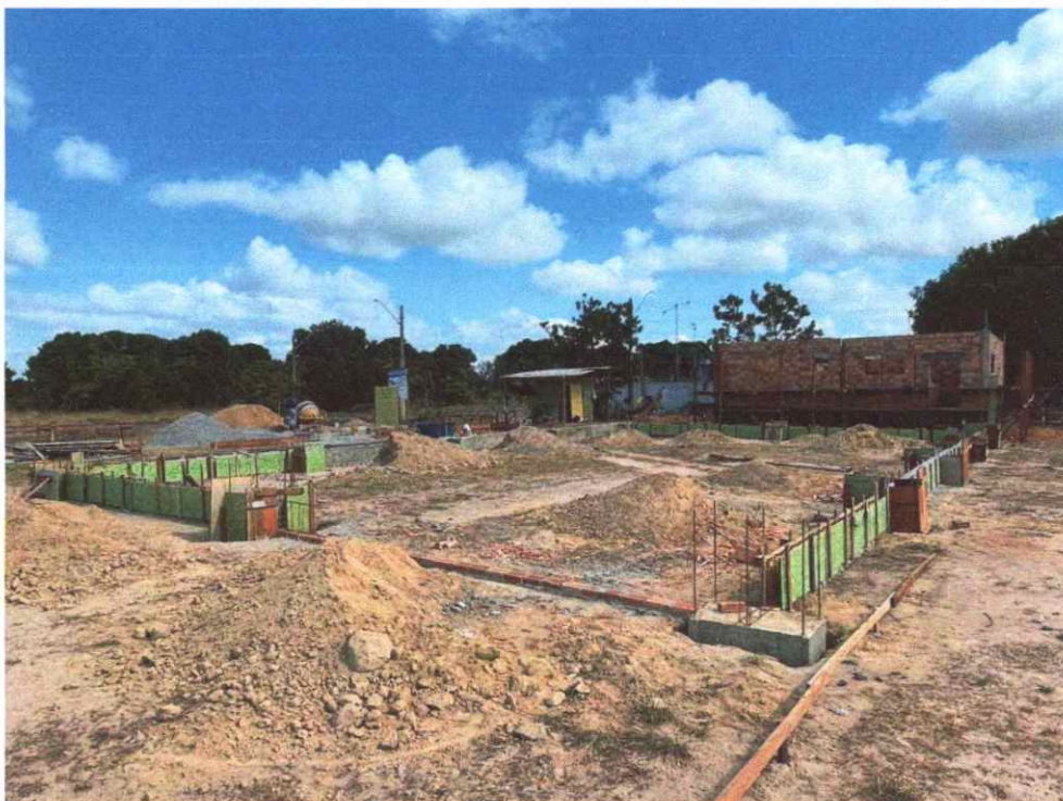
Figura 24: viga baldrame concretada - parte GALPÃO
