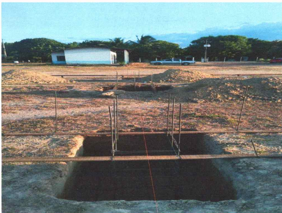
Figura 16: armação da sapata - parte GALPÃO
