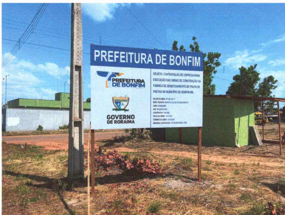
Figura 6: placa de identificação da obra
