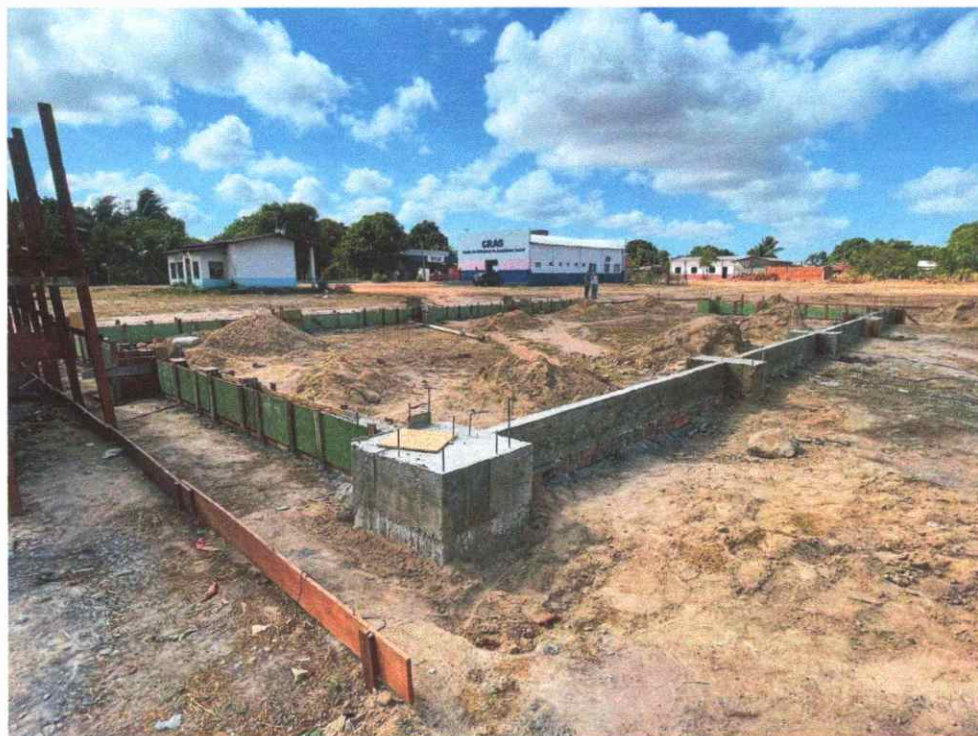
Figura 22: viga baldrame concretada - parte GALPÃO
