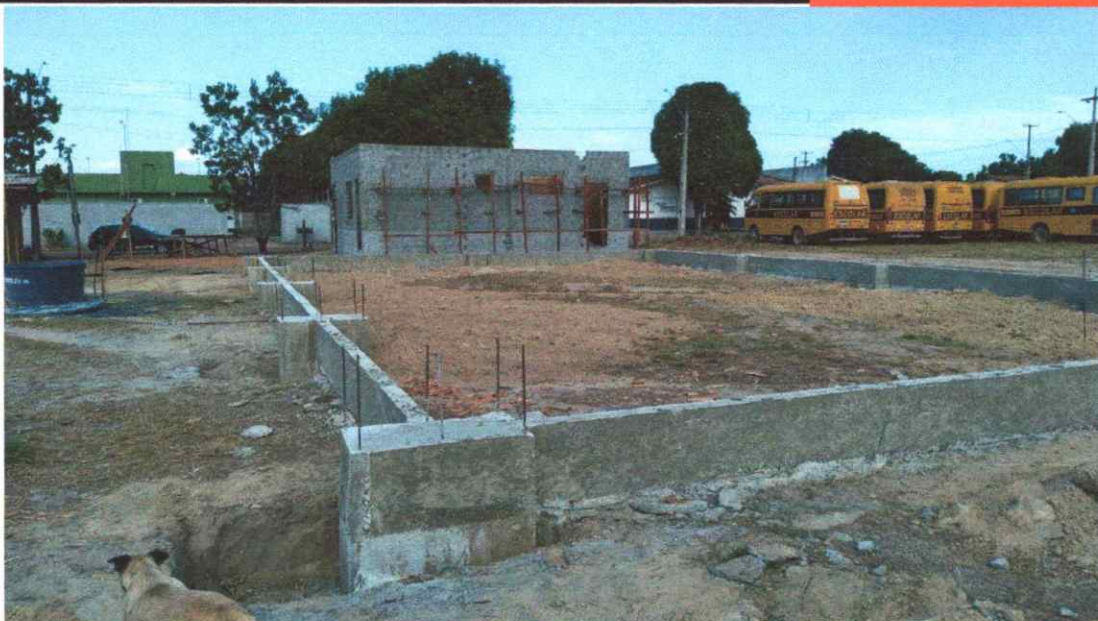
Figura 25: viga baldrame concretada - parte GALPÃO
