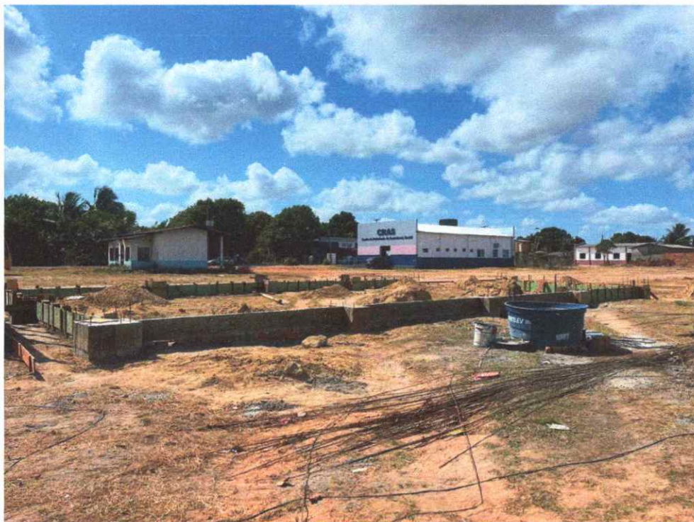
Figura 20: viga baldrame concretada - parte GALPÃO
