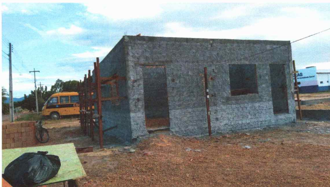
Figura 28: chapisco alvenaria - parte administrativa
