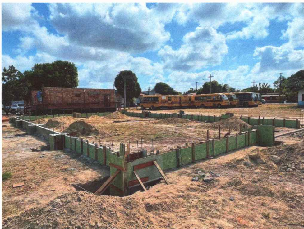
Figura 26: viga baldrame concretada - parte GALPÃO
