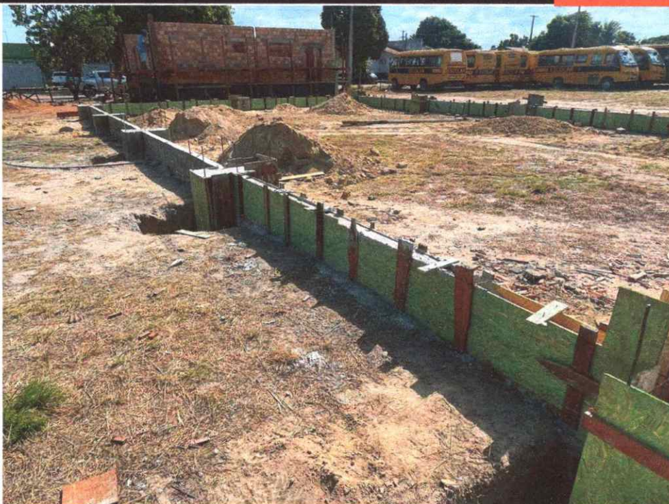
Figura 23: viga baldrame concretada - parte GALPÃO
