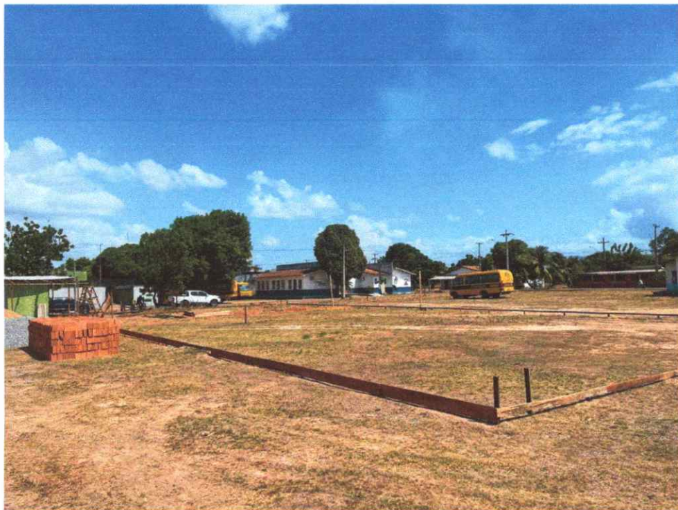
Figura 4: limpeza do terreno e locação da obra
