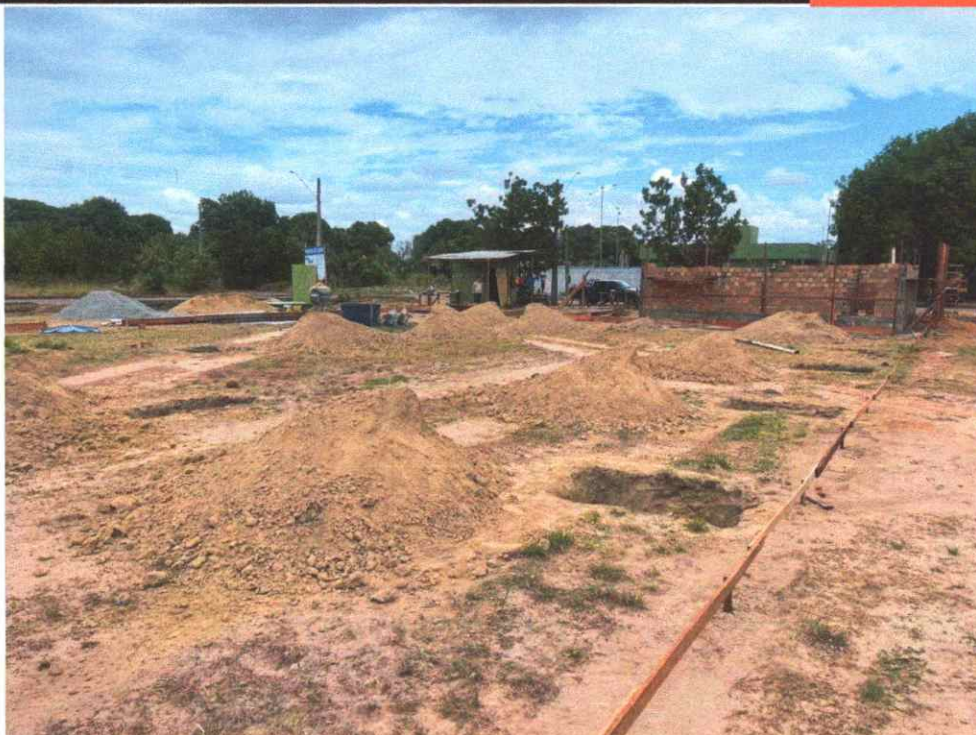
Figura 11: escavação fundação GALPÃO
