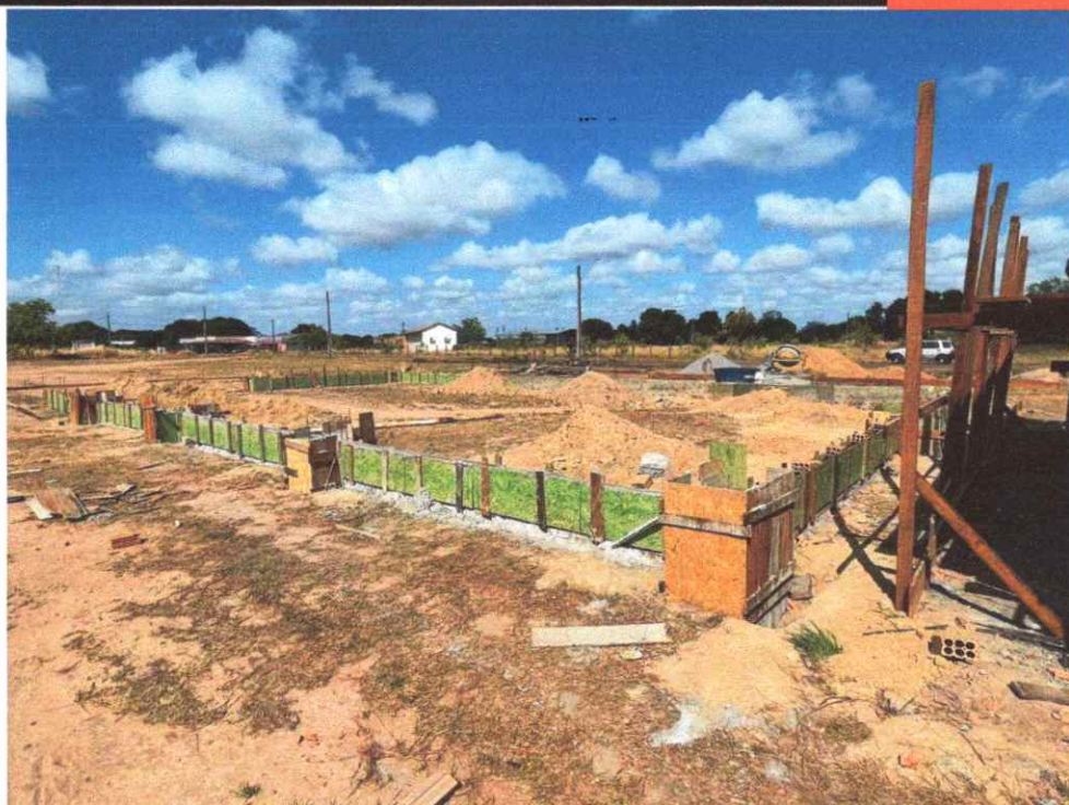
Figura 21: viga baldrame concretada - parte GALPÃO
