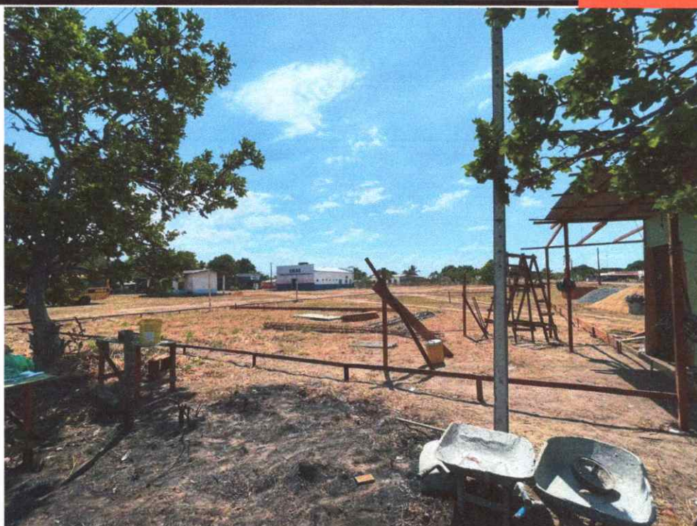
Figura 7: gabarito da obra
