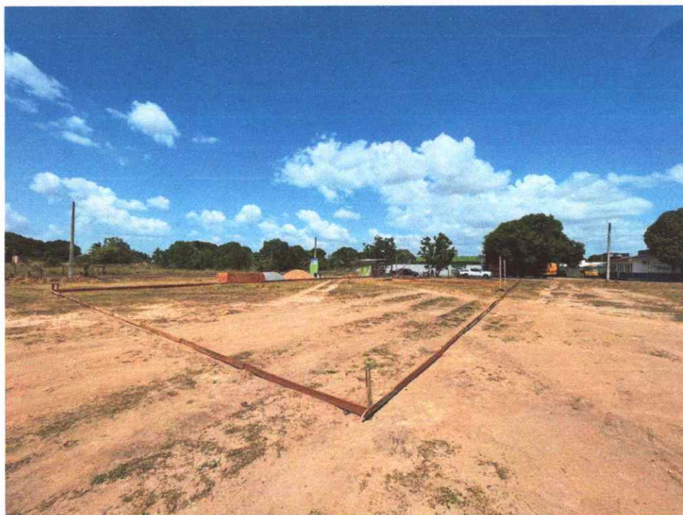
Figura 2: limpeza do terreno e locação da obra
