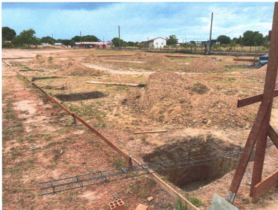
Figura 12: escavação fundação GALPÃO
