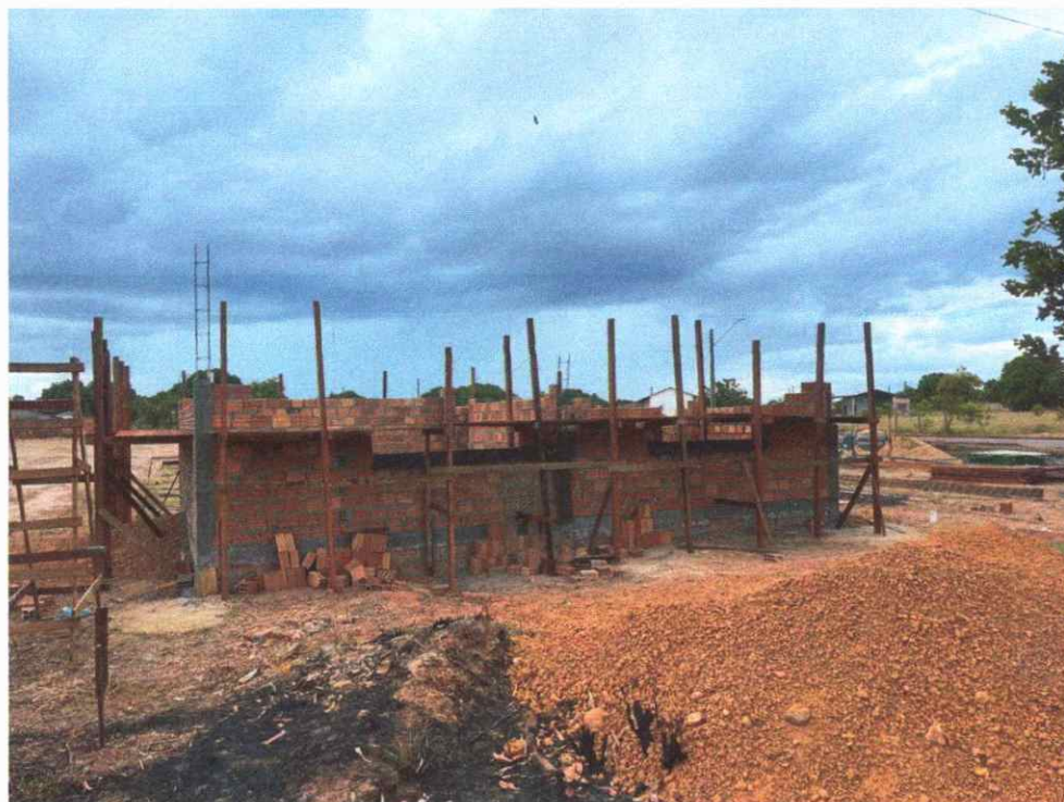
Figura 10: alvenaria de vedação - parte administrativa
