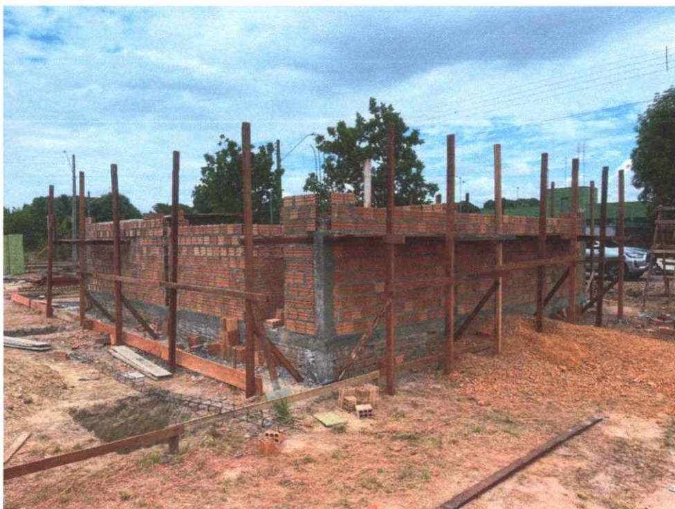
Figura 14: alvenaria de vedação - parte administrativa
