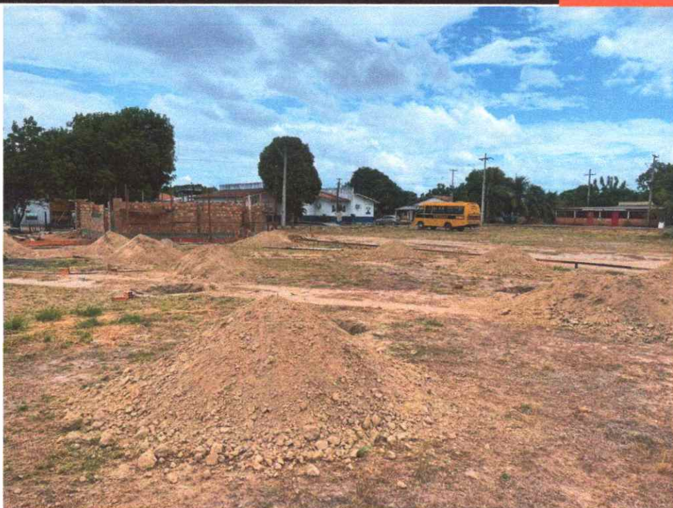
Figura 13: escavação fundação GALPÃO
