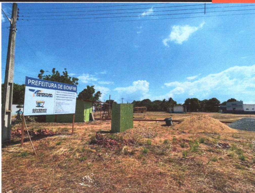
Figura 5: placa de identificação da obra e montagem de barracão
