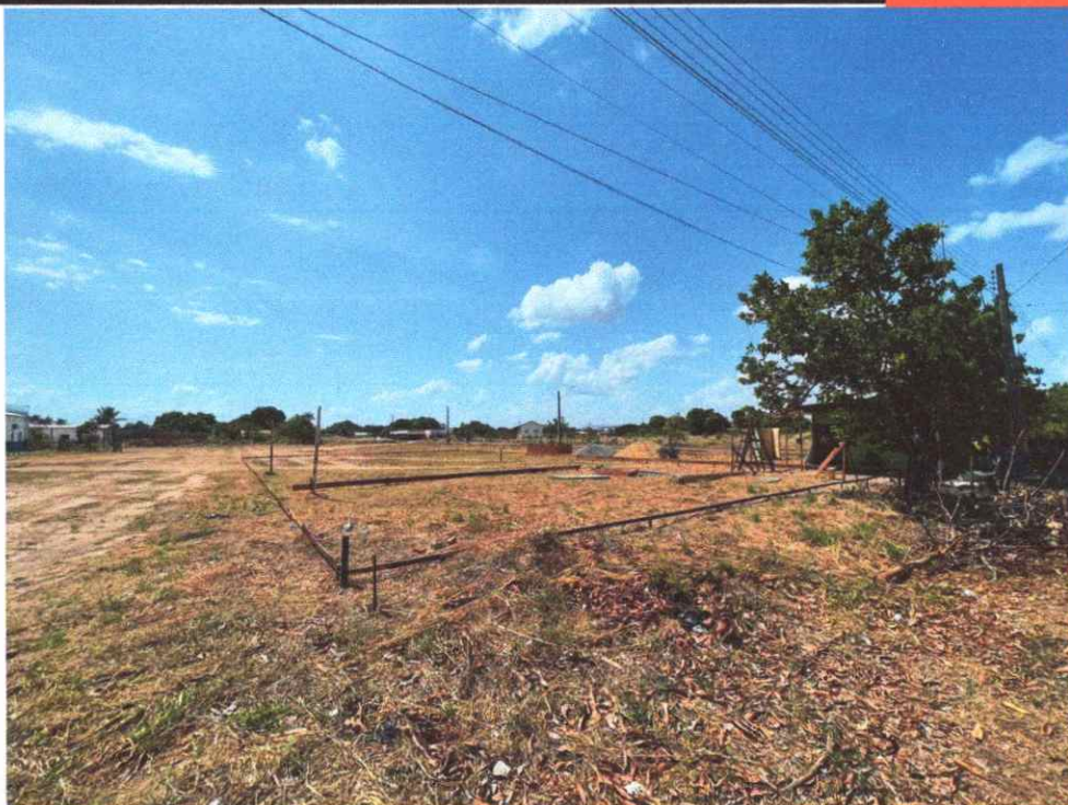
Figura 1: limpeza do terreno e locação da obra
