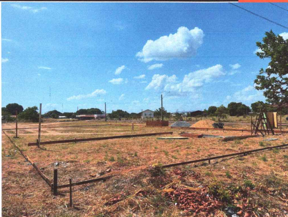
Figura 3: limpeza do terreno e locação da obra
