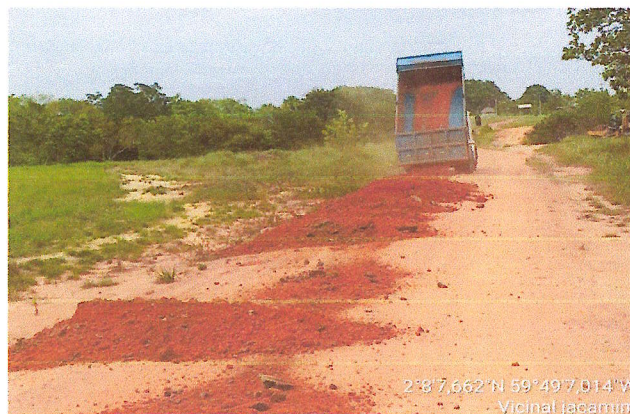
RECOMPOSIÇÃO DE REVESTIMENTO
