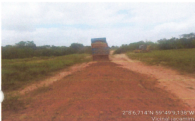
RECOMPOSIÇÃO DE REVESTIMENTO
