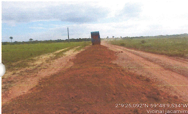
RECOMPOSIÇÃO DE REVESTIMENTO
