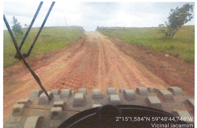
RECOMPOSIÇÃO DE REVESTIMENTO
