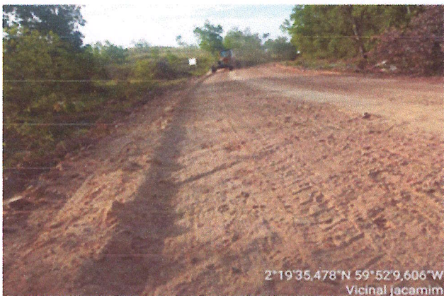
REGULARIZAÇÃO DE SUBLEITO
