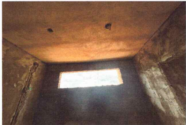
BANHEIROS EXECUÇÃO DE ALVENARIA
