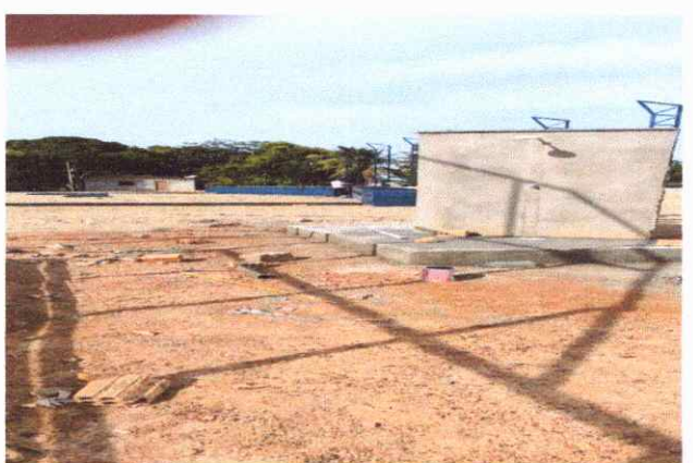
CALÇADAS EXECUÇÃO DE PASSEIO
