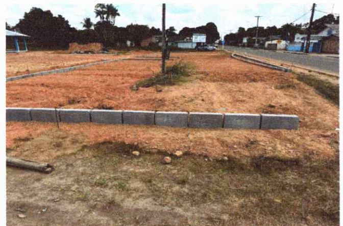
CALÇADAS ASSENTAMENTO DE MEIO FIO
