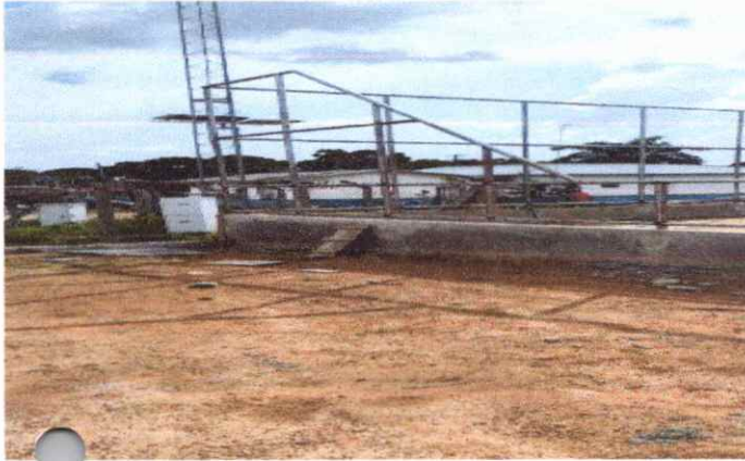
EXECUÇÃO DE PISO ATERRO MANUAL
