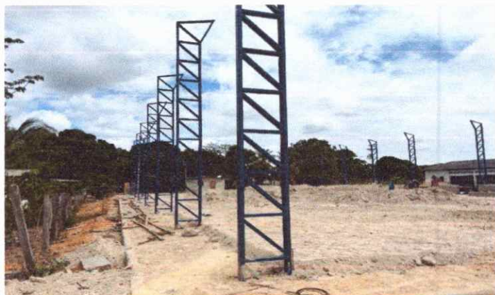
ESTRUTURAS INSTALAÇÃO DE PILAR METÁLICO
