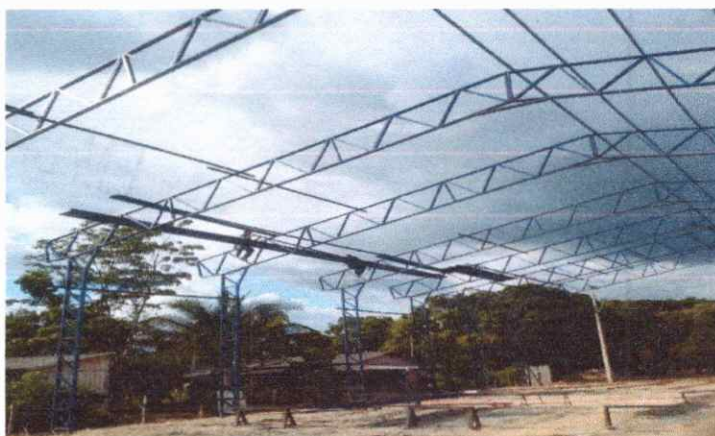
ESTRUTURAS INSTALAÇÃO DE TERÇAS METÁLICO
