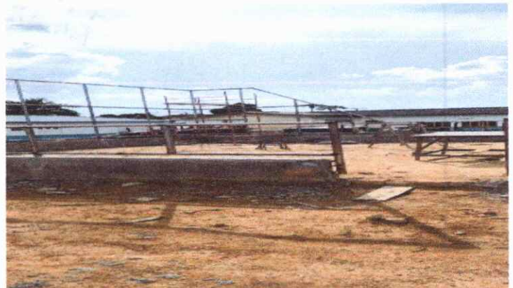
EXECUÇÃO DE PISO ATERRO MANUAL
