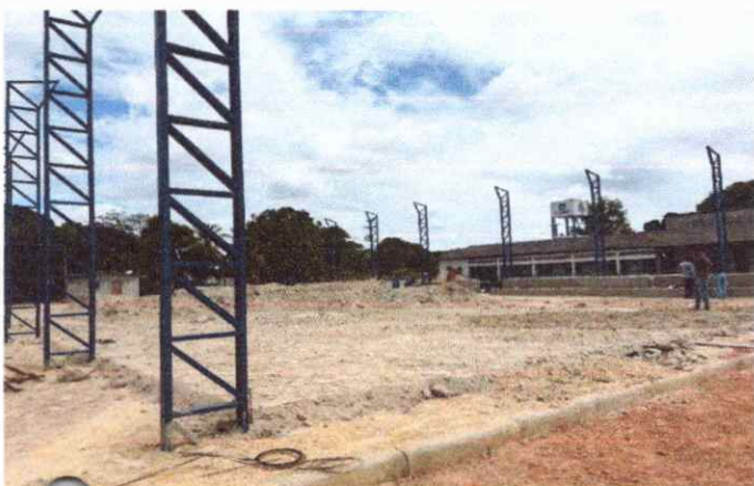
ESTRUTURAS INSTALAÇÃO DE PILAR METÁLICO
