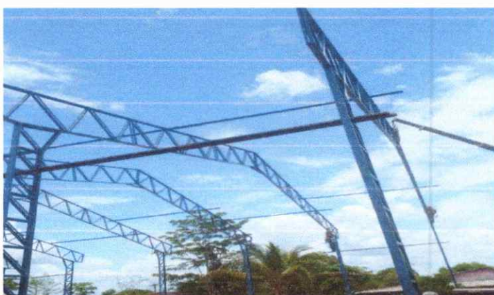
ESTRUTURAS INSTALAÇÃO DE TERÇAS METÁLICO
