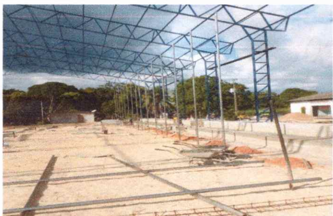
ESTRUTURAS INSTALAÇÃO DE TERÇAS METÁLICO
