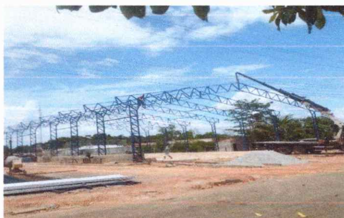
ESTRUTURAS INSTALAÇÃO DE TERÇAS METÁLICO
