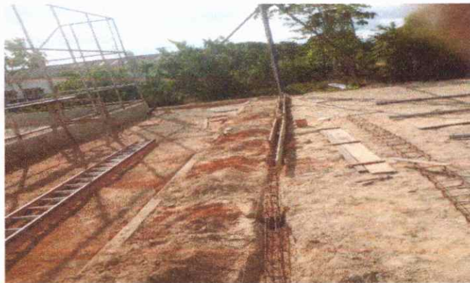
EXECUÇÃO DE PISO ATERRO MANUAL
