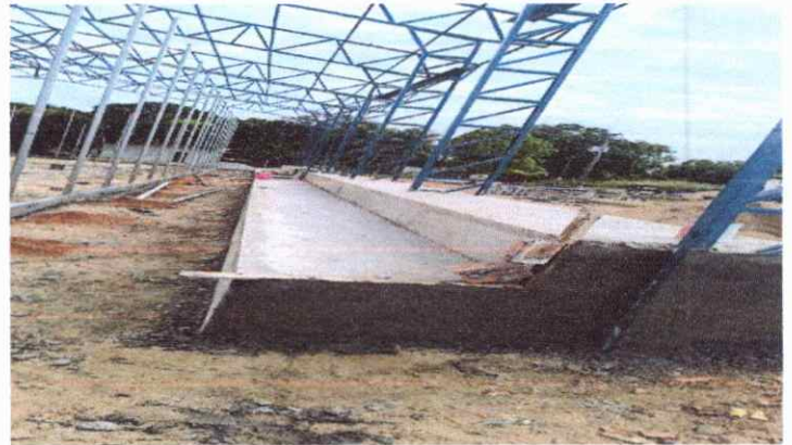
EXECUÇÃO DE PISO ATERRO MANUAL
