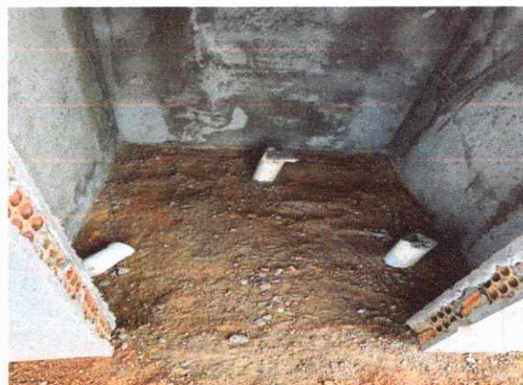
EXECUÇÃO DE PAREDES ALVENARIA, CHAPISCO E REBOCO
