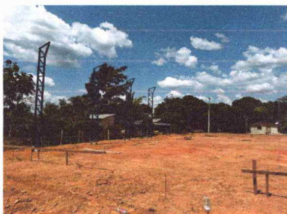
ESTRUTURAS INSTALAÇÃO DE PILAR METÁLICO
