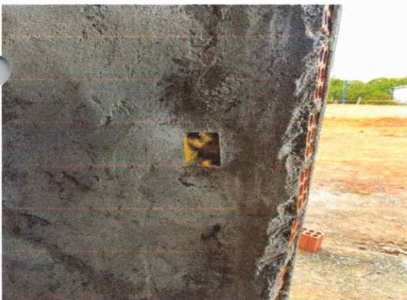
EXECUÇÃO DE PAREDES ALVENARIA, CHAPISCO E REBOCO
