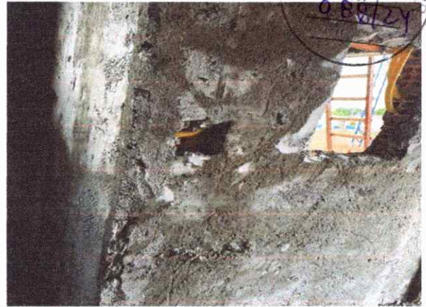
EXECUÇÃO DE PAREDES ALVENARIA, CHAPISCO E REBOCO
