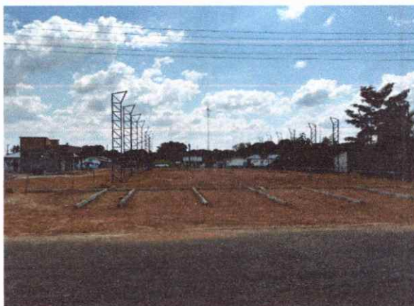
ESTRUTURAS INSTALAÇÃO DE PILAR METÁLICO
