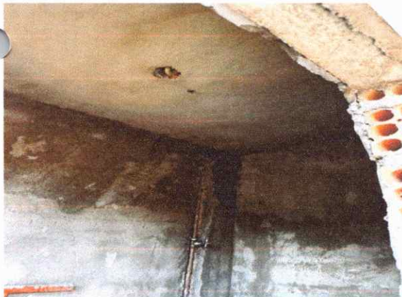
EXECUÇÃO DE PAREDES ALVENARIA, CHAPISCO E REBOCO
