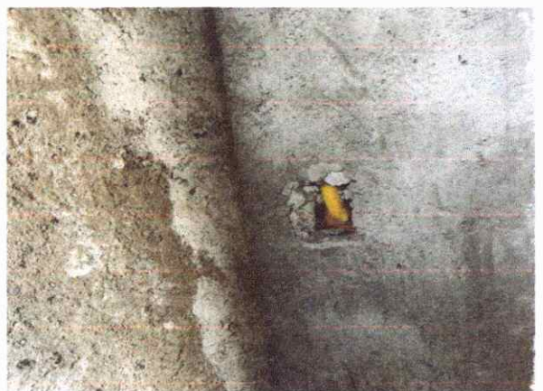
EXECUÇÃO DE PAREDES ALVENARIA, CHAPISCO E REBOCO
