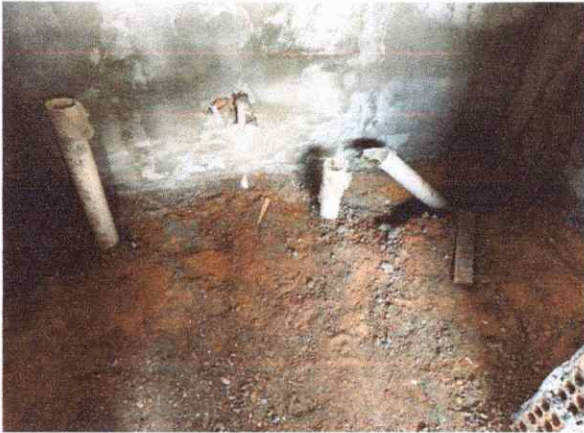
EXECUÇÃO DE PAREDES ALVENARIA, CHAPISCO E REBOCO
