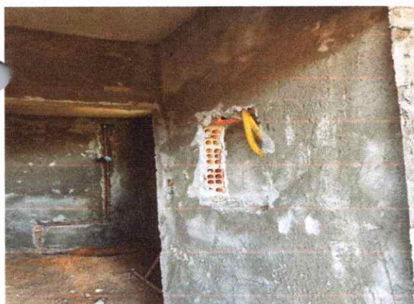
EXECUÇÃO DE PAREDES ALVENARIA, CHAPISCO E REBOCO
