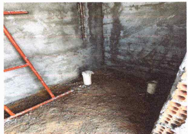
EXECUÇÃO DE PAREDES ALVENARIA, CHAPISCO E REBOCO
