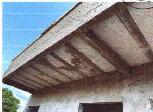
EXECUÇÃO DE PAREDES ALVENARIA, CHAPISCO E REBOCO
