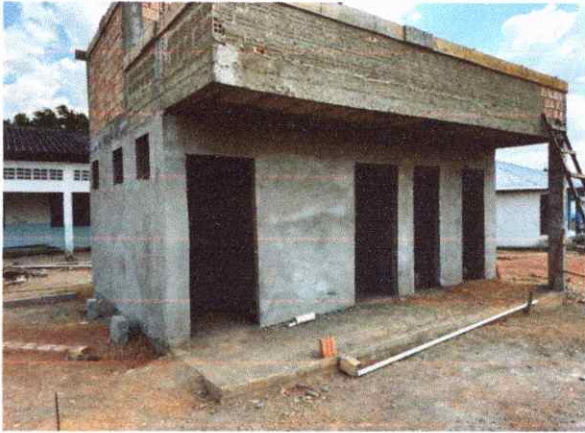
EXECUÇÃO DE PAREDES ALVENARIA, CHAPISCO E REBOCO
