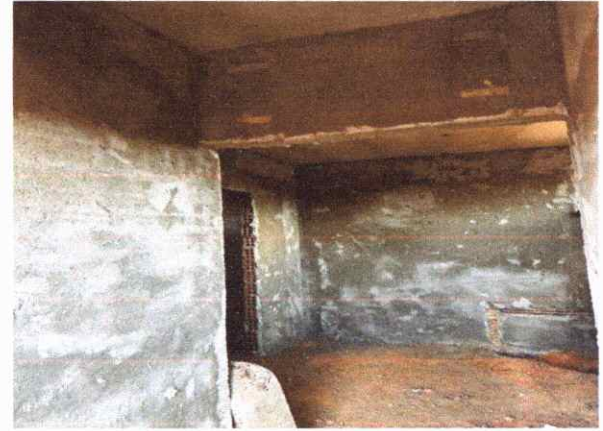
EXECUÇÃO DE PAREDES ALVENARIA, CHAPISCO E REBOCO
