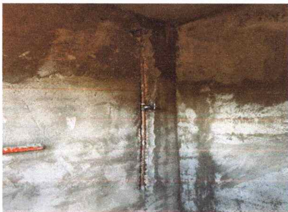
EXECUÇÃO DE PAREDES ALVENARIA, CHAPISCO E REBOCO
