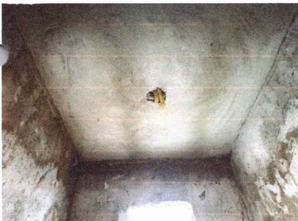
EXECUÇÃO DE PAREDES ALVENARIA, CHAPISCO E REBOCO
