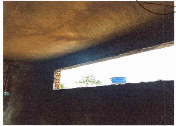
EXECUÇÃO DE PAREDES ALVENARIA, CHAPISCO E REBOCO
