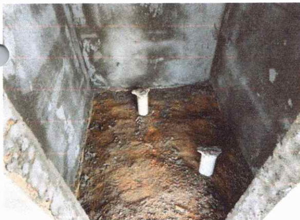
EXECUÇÃO DE PAREDES ALVENARIA, CHAPISCO E REBOCO
