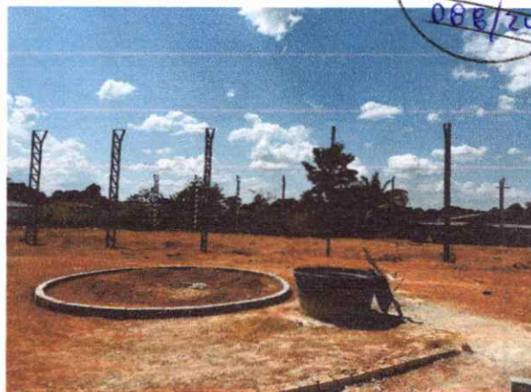
ESTRUTURAS INSTALAÇÃO DE PILAR METÁLICO
