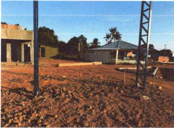
ESTRUTURAS INSTALAÇÃO DE PILAR METÁLICO
