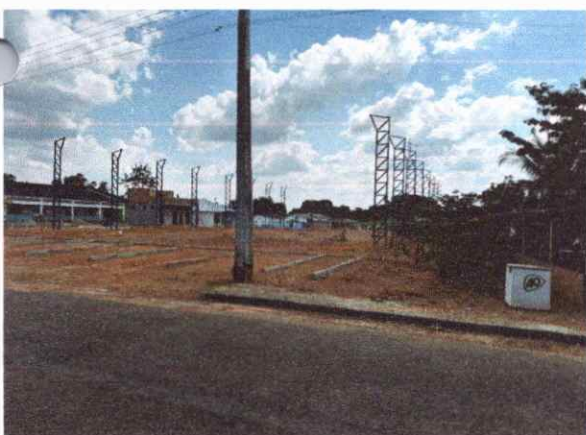
ESTRUTURAS INSTALAÇÃO DE PILAR METÁLICO
