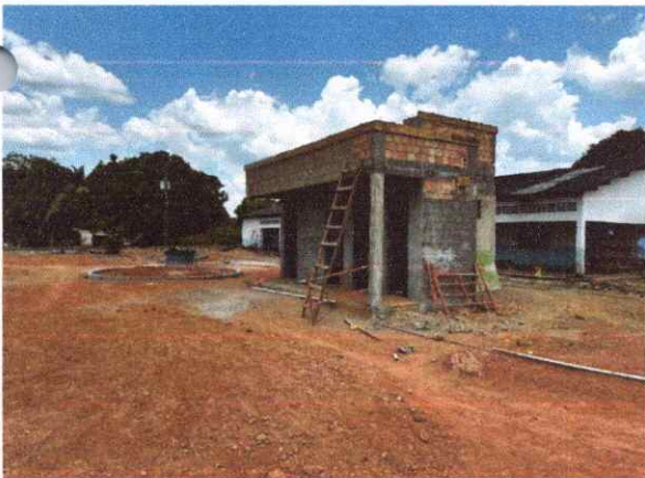
EXECUÇÃO DE PAREDES ALVENARIA, CHAPISCO E REBOCO
