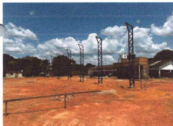
ESTRUTURAS INSTALAÇÃO DE PILAR METÁLICO
