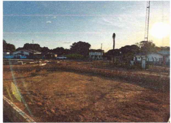
EXECUÇÃO DE PISO EM CONCRETO ALVENARIA DE EMBASAMENTO
