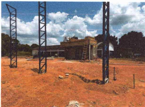
ESTRUTURAS INSTALAÇÃO DE PILAR METÁLICO
