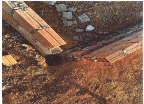
EXECUÇÃO DE PISO EM CONCRETO ALVENARIA DE EMBASAMENTO
