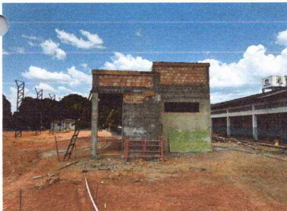
EXECUÇÃO DE PAREDES ALVENARIA
